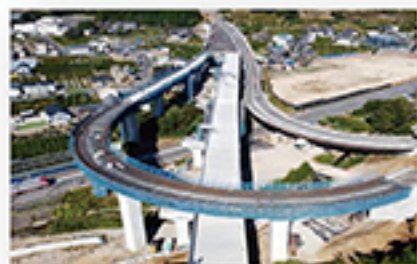
工事が進む国道23号線蒲郡バイパス
