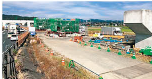
工事が進む国道23号線蒲郡バイパス
