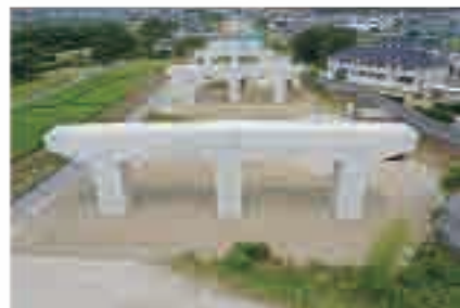
工事が進む国道23号線蒲郡バイパス
